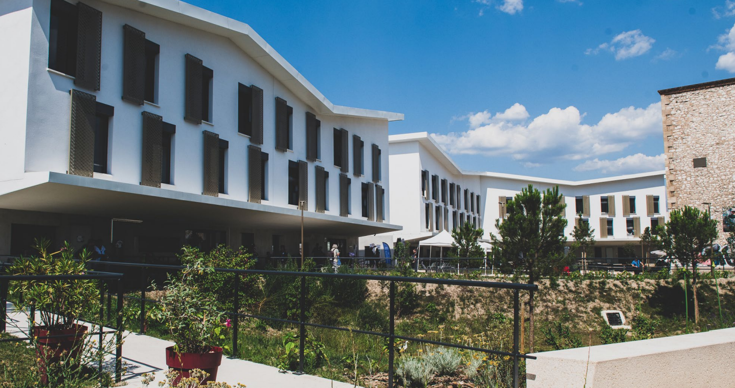
Centre d'Hébergement d'Urgence, La Minoterie 15 e arrondissement
